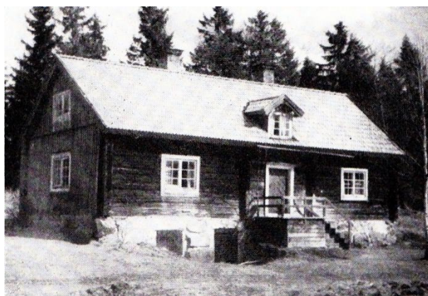
Det gamla brukskontoret, är nu flyttat till annan plats.
